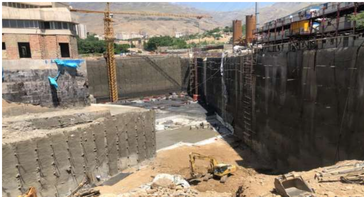
اجرای عملیات گودبرداری محوطه جنوبی در اردیبهشت ۱۴۰۰
