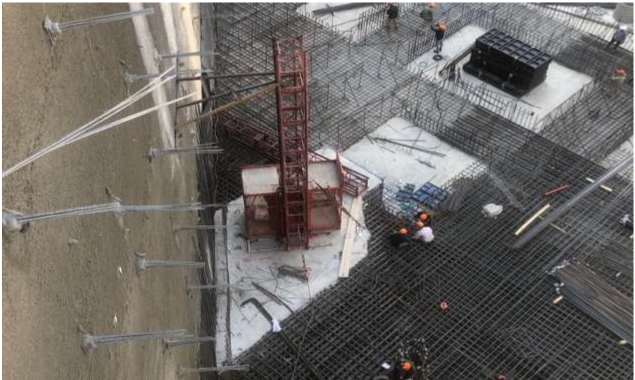
نصب یک دستگاه بالابر کارگاهی (آلیماک) در اردیبهشت ۱۴۰۰
