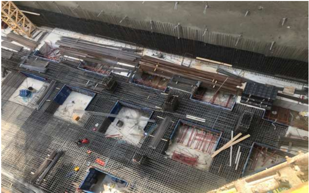
اجرای عملیات آرماتوربندی و قالب بندی در محوطه شمالی در اردیبهشت ۱۴۰۰
