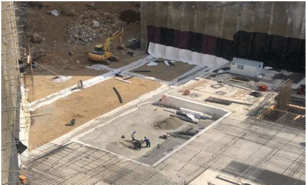
اجرای عملیات زهکشی فونداسیون در محوطه شمالی در اردیبهشت ۱۴۰۰
