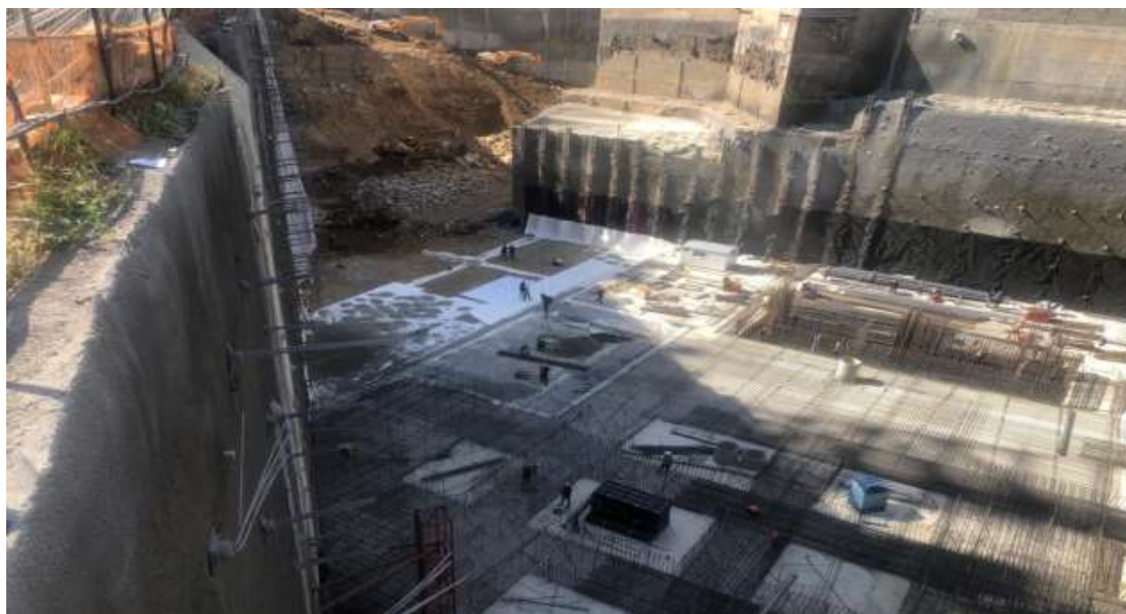
اجرای عملیات فونداسیون و زهکشی محوطه شمالی در اردیبهشت ۱۴۰۰
